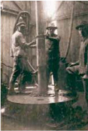
Drei Kessel dienten zur Erzeugung des Dampfdruckes für den Antrieb des Bohrers, der sich durch das Kalkgestein, Fels, Sand und Salz quälte.
